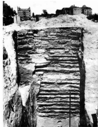
Рис. 4. Тилова стінка зрубів валу Ярослава, фото розкопок 1952 р. (за М.К. Каргером).
