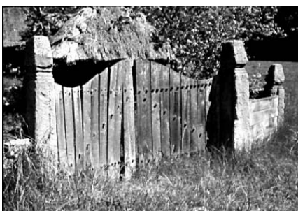
297.5.7.3. Куча — с. Гарячинці, Ново-ушицький р-н, Хмельницька обл., поч. 20 ст. (архит.). Одноділля, прямокутна в плані. Карка с утворюють дубові стовпи, скріплені знизу й вгорі обв'яз-
