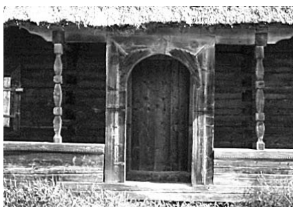
297.2.1.3.1. Вхід на галерею.
