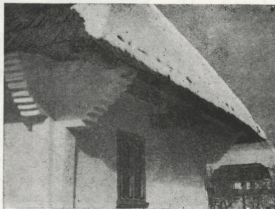
Рис. 29. Дерев'яні кронштейни, які підтримують звис даху. Двадцять років; с. Садгора, Чернівецької обл. Фото Ю. Хохла.
