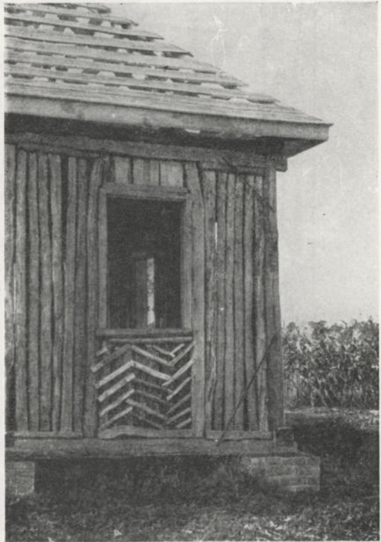
Рис. 139. Фрагмент каркасної стіни з вертикальною забірною («всторч»). Сорокові роки.
