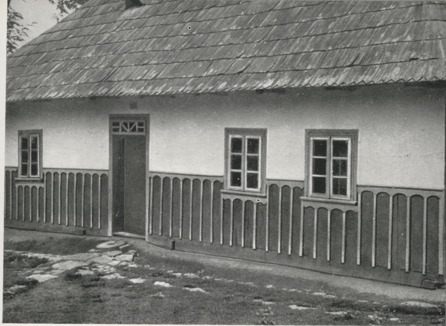
44. Обробка нижньої частини стіни жилого будинку. Тридцяті роки; с. Балива, Чернівецької обл. За матеріалами МА УРСР.
