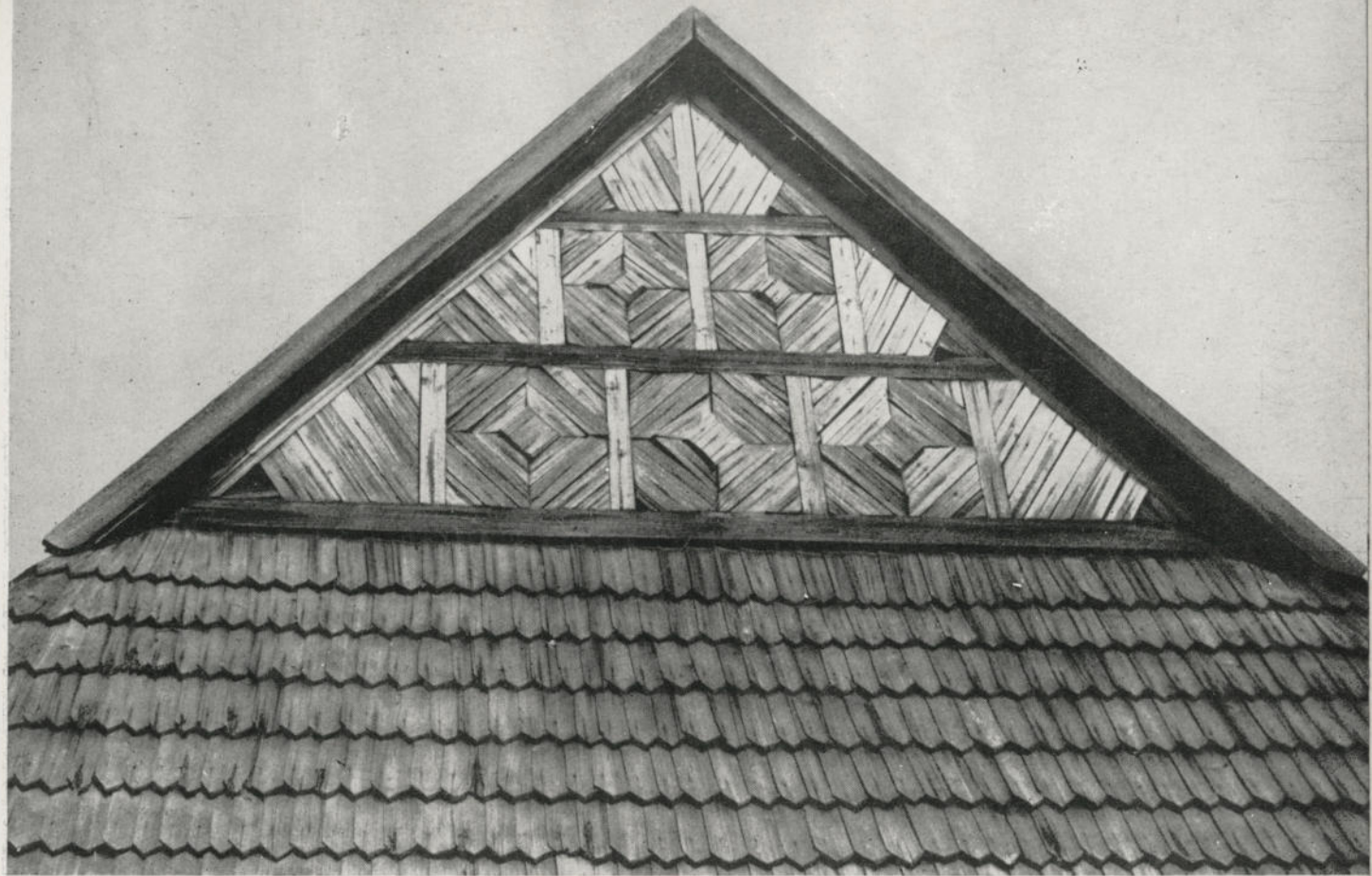
41. Обробка фронтона чотирисхилого даху. Тридцять роки; с. Старий Косів, Станіславської обл. За матеріалами МА УРСР.
