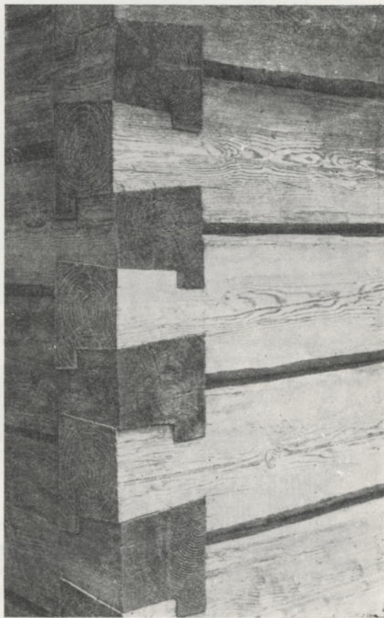
Рис. 137. Фрагменти стін зрубу без лишків. Тридцять роки; Станіславська обл. Фото автора та З. Петрової.
