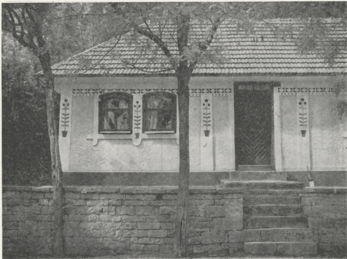
Рис. 148. Пластична обробка стін жилого будинку. Сорокові роки; с. Ріхтецька Слобідка, Хмельницької обл. Фото автора.
