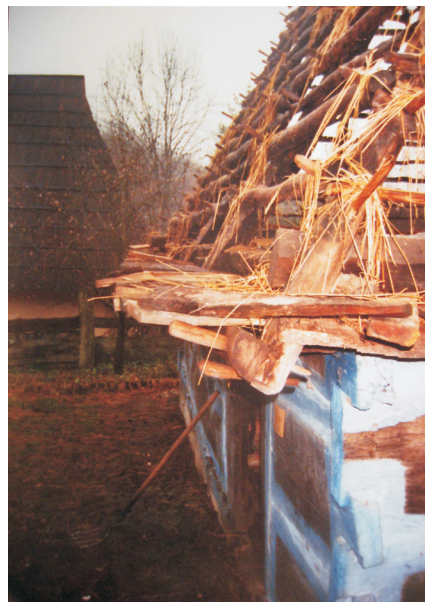
Фото 36: Хата XVII–XVIII ст. зі с. Теремлі Тячівського р-ну Закарпатської обл. Фрагмент каркасу даху, підготовленого до покриття соломою “внатрус”. Реставрація 2006 р., НМНАПУ, м. Київ. Фото М. Матійчука
