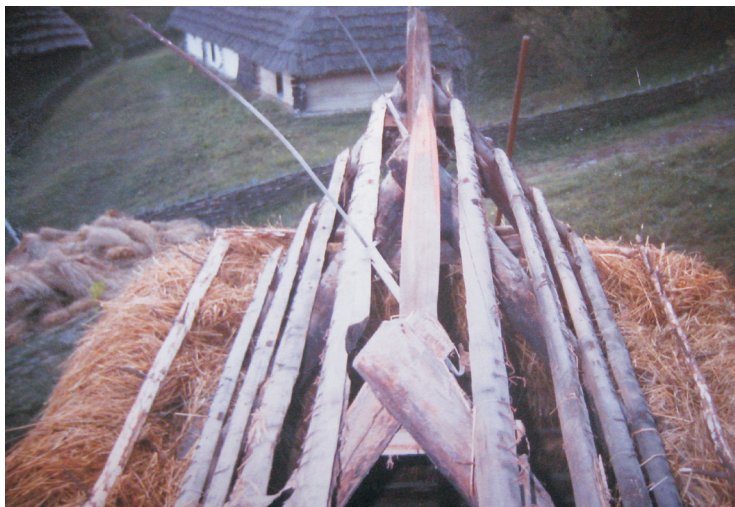
Фото 33: Фрагмент даху млина зі с. Пилипця Міжгірського р-ну Закарпатської обл. Процес покриття даху соломною “внатрус”. Реставрація 2006 р., НМНАПУ, м. Київ. Фото М. Матійчука
