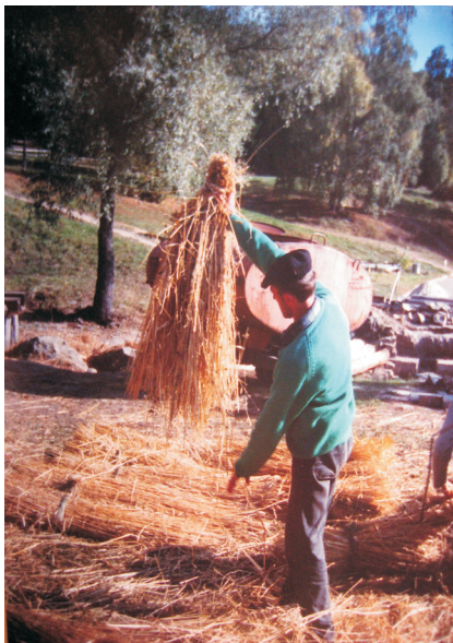
Фото 46: Покривання даху млина зі с. Пилипця Міжгірського р-ну Закарпатської обл. Майстер-покрівельник виготовляє “жупу”. НМНАПУ, м. Київ, 2006 р. Фото М. Матійчука
