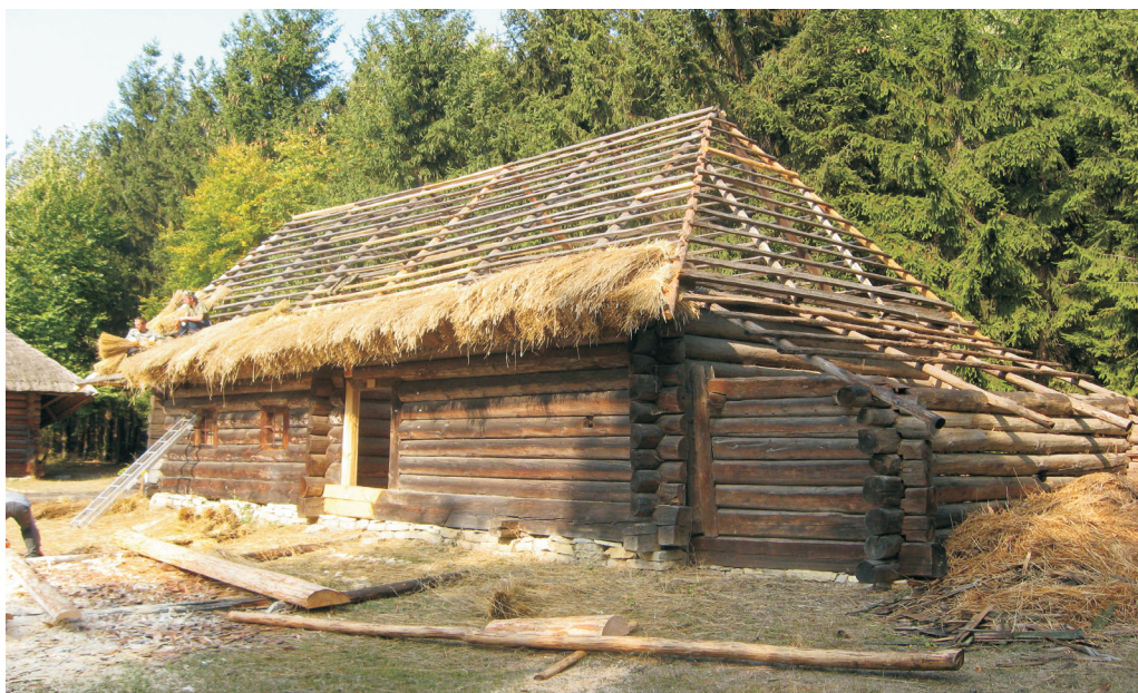
Фото 42: Хата кінця XIX ст. зі с. Липовиці Рожнятівського р-ну Івано-Франківської обл. Процес покриття даху сніпками. Експозиція НМНАПУ, 2009 р. Фото М. Матійчука
