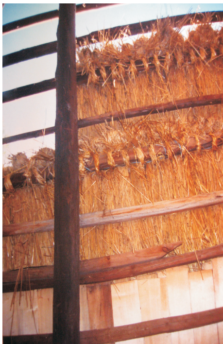
Фото 32: Фрагмент даху млина зі с. Пилипця Міжгірського р-ну Закарпатської обл. Процес покриття даху “жупами”. Реставрація 2006 р., НМНАПУ, м. Київ. Фото М. Матійчука
