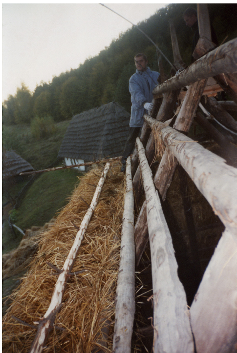
Фото 31: Фрагмент даху млина зі с. Пилипця Міжгірського р-ну Закарпатської обл. Процес покриття даху соломною “внатрус”. Реставрація 2006 р., НМНАПУ, м. Київ. Фото М. Матійчука
