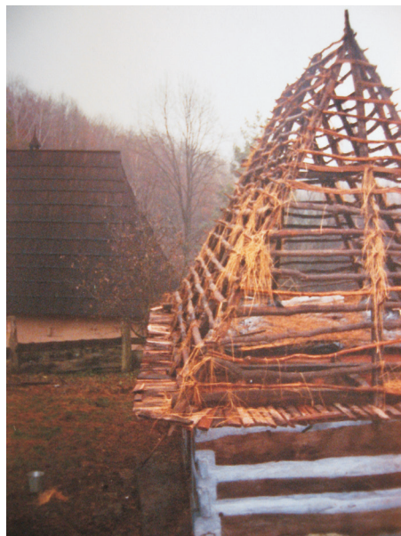
Фото 35: Хата XVII–XVIII ст. зі с. Теремлі Тячівського р-ну Закарпатської обл. Каркас даху, підготовлений до покриття соломою “внатрус”. Реставрація 2006 р., НМНАПУ, м. Київ. Фото М. Матійчука
