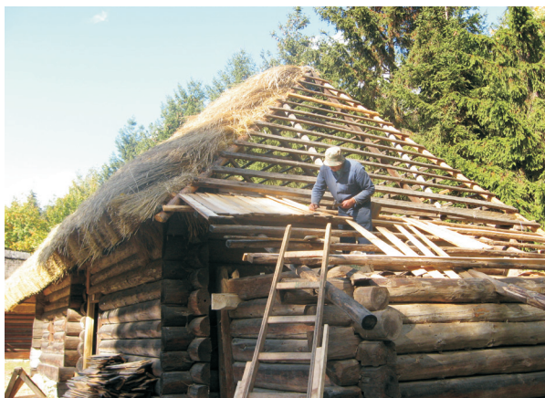
Фото 43: Хата кінця XIX ст. зі с. Липовиці Рожнятівського р-ну Івано-Франківської обл. Процес покриття даху колотою дошкою. Експозиція НМНАПУ, 2009 р. Фото М. Матійчука
