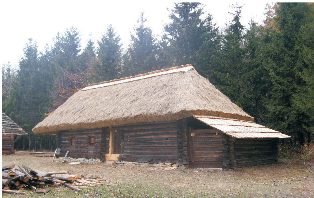
Фото 41: Хата кінця XIX ст. зі с. Липовиці Рожнятівського р-ну Івано-Франківської обл. — після реставрації. Дах покритий сніпками і колотою дошкою. На гребені дерев'яний дашок. Експозиція НМНАПУ, 2010 р. Фото М. Матійчука
